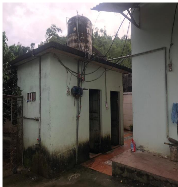
Ảnh 6: Hiện trạng nhà tắm + nhà vệ sinh
