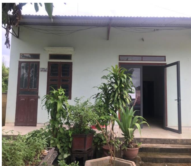
Ảnh 7: Hiện trạng nhà điều hành + bảo vệ
