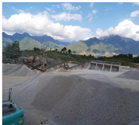
Ảnh 8: Hiện trạng trạm nghiền và bãi chứa đá
