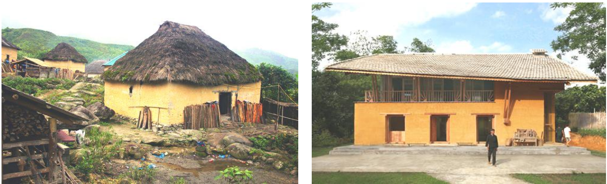
Hình 3. Nhà trình tường của dân tộc Hà Nhì
