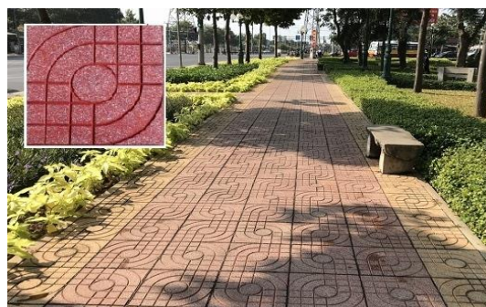
Mẫu 2: Gạch lát Terrazzo. Ứng dụng phổ biến lát vỉa hè. Gạch có nhiều kiểu khuôn
