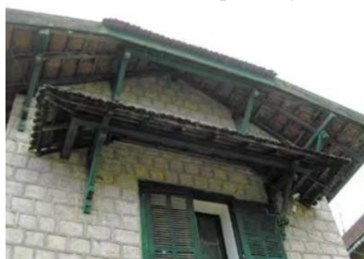
Mái lợp ngói, khung vì gỗ
