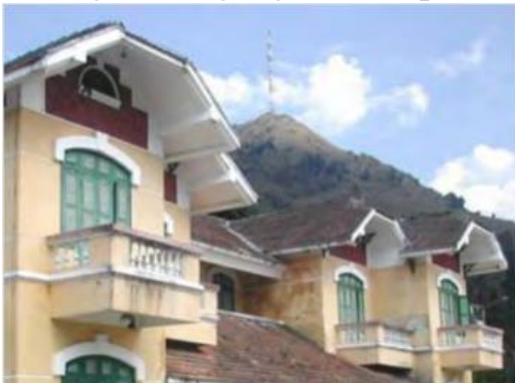
Mái dốc đổ bê tông, lợp giả ngói
