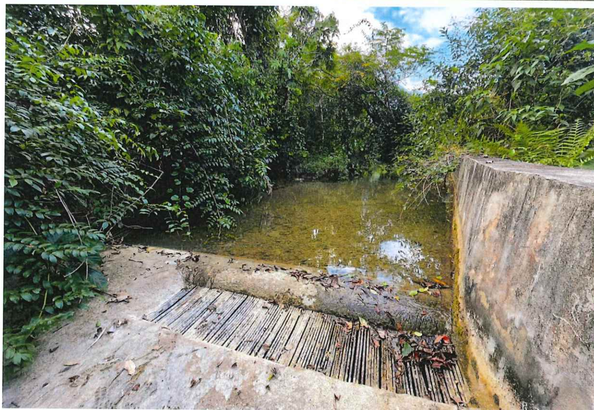
Hình 11. Công trình thủy lợi Nậm Chăn
