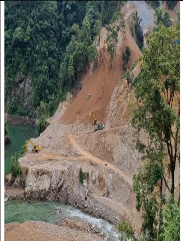
Hình 2: Khu vực xây dựng tuyến đường hầm
