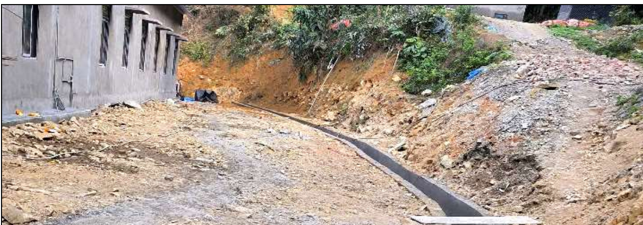
Rãnh thoát nước sau nhà máy quản lý vận hành
