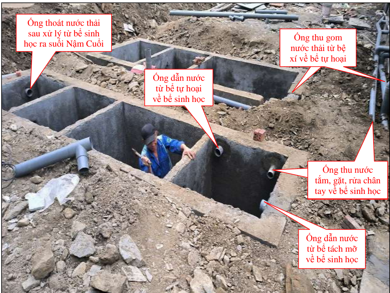
Hình 3.9. Hình ảnh về hệ thống thu gom nước thải sinh hoạt của dự án
