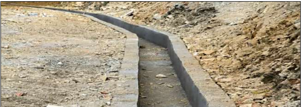
Rãnh thoát nước khu nhà máy
