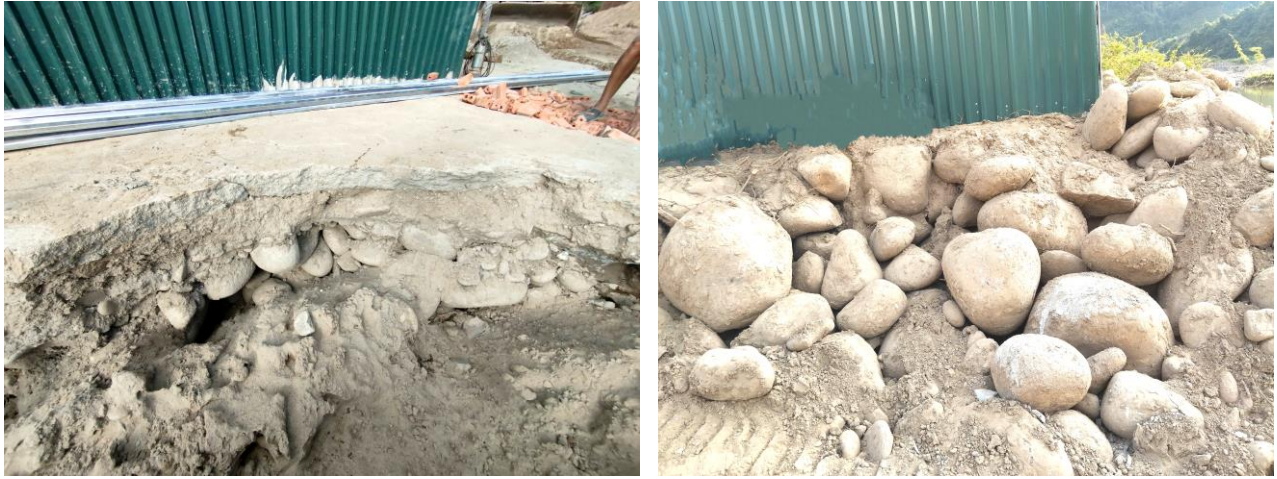
Hình 3.1. Hình ảnh thoát nước mưa qua hố thấm và nền địa chất tại cơ sở
