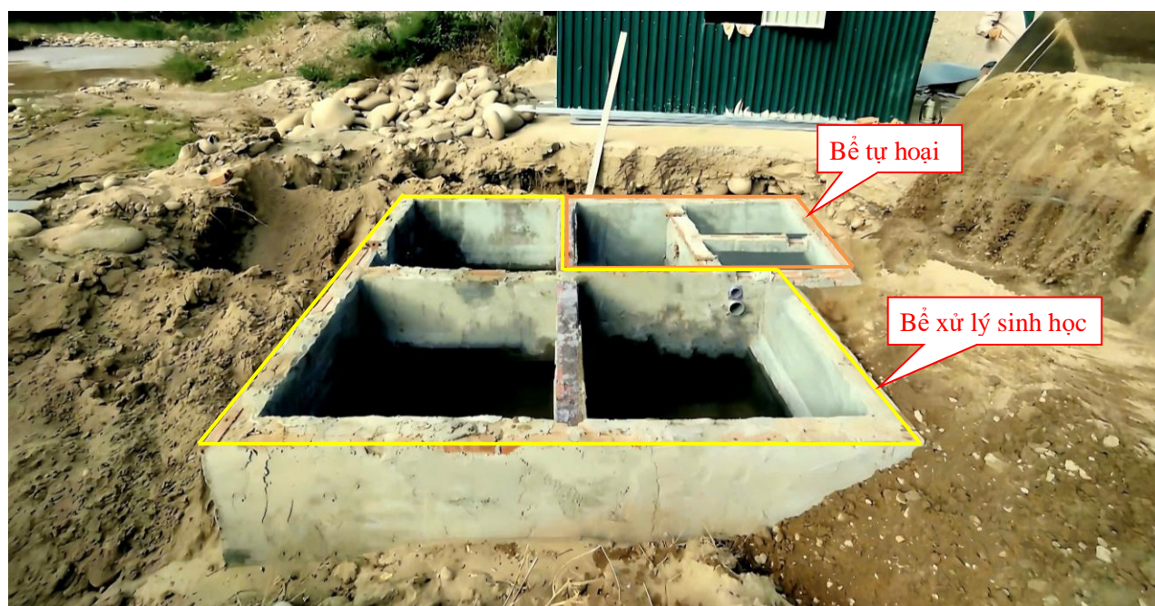
Tổng thể về bể tự hoại và bể xử lý sinh học
