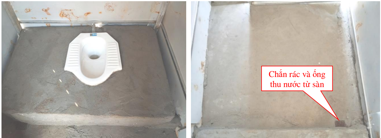
Hình 3.3. Một số hình ảnh về hệ thống thu gom nước thải sinh hoạt
