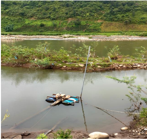
Bơm cấp nước từ sông Nậm Mu
