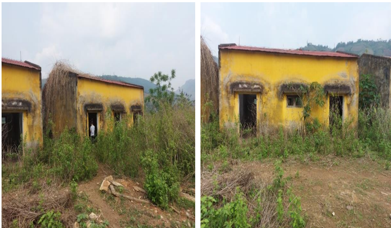
Hình 1. 21. 2 nhà kho dự kiến cải tạo thành nhà chứa chất thải rắn và nhà vệ sinh
