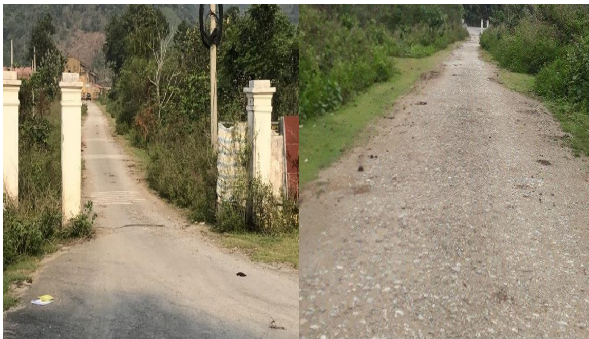
Hình 1. 28. đường giao thông từ nối từ QL12 vào cổng tường rào nhà máy
