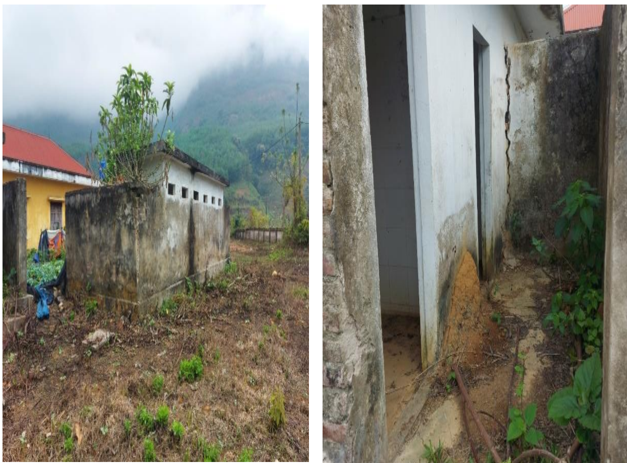
Hình 4. 3. Ảnh chụp nhà vệ sinh nhà máy giấy cũ
