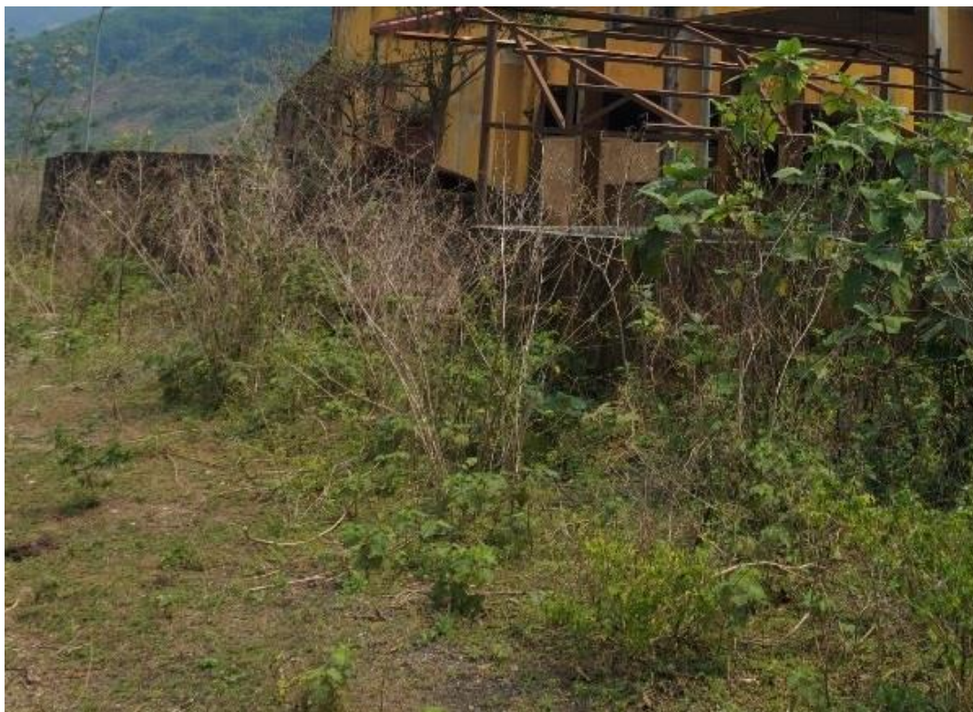
Hình 1. 23. Ảnh chụp khu vực bể nước hiện trạng
