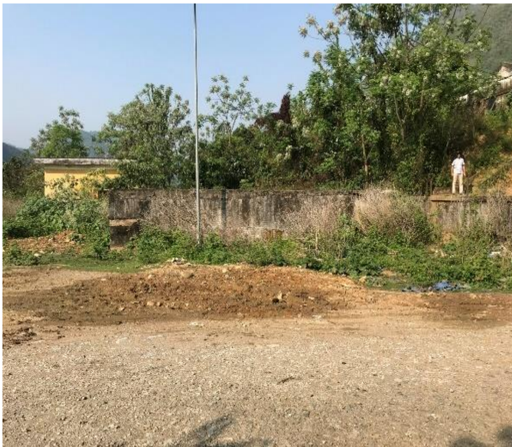
Hình 1. 14. Ảnh chụp bể nước xây nổi hiện trạng
