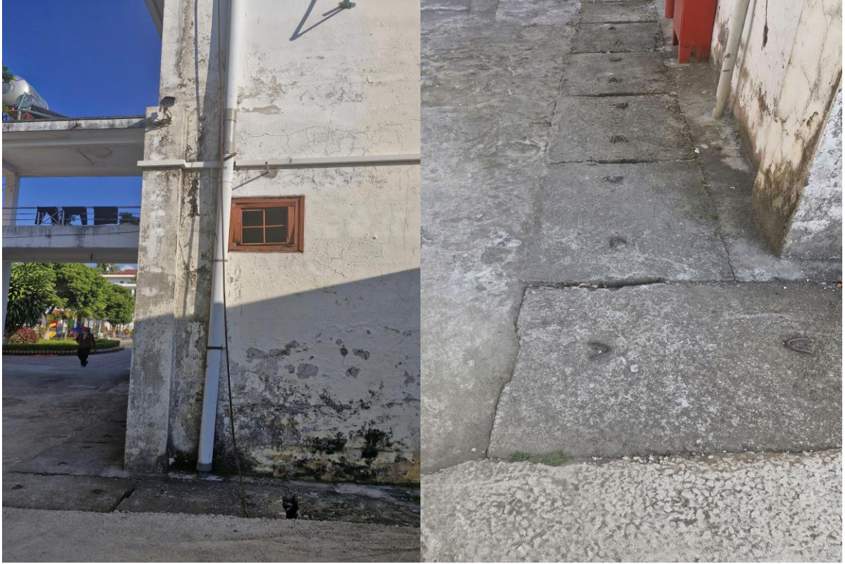
Hình 3.2. Đường ống thu gom và mương dẫn thu gom thoát nước mưa
