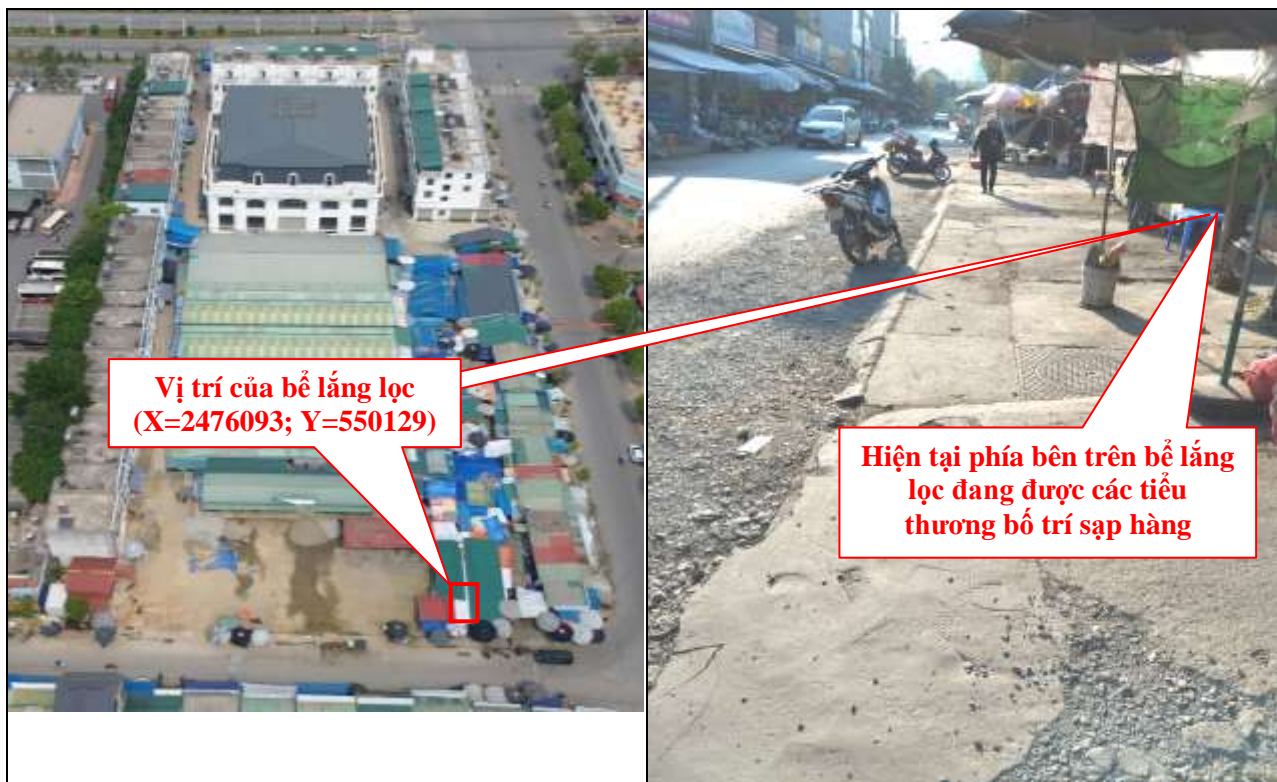
Hình 3.22. Vị trí, hình ảnh của bể lắng lọc
