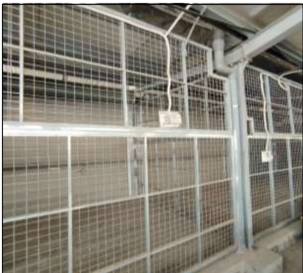
Ống thoát nước mưa mái chợ ngoài trời có mái che
