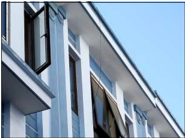
Sê nô thu nước mưa mái nhà Ki ốt
