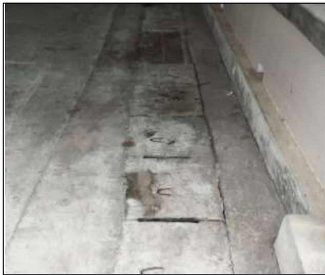
Hình 3.12. Rãnh B300mm thu gom nước thải chợ ngoài trời có mái che
