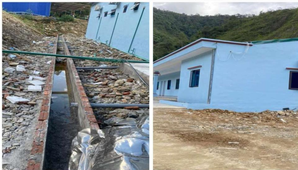
**Hình 5: Hệ thống thu gom, thoát nước mưa của Dự án**
