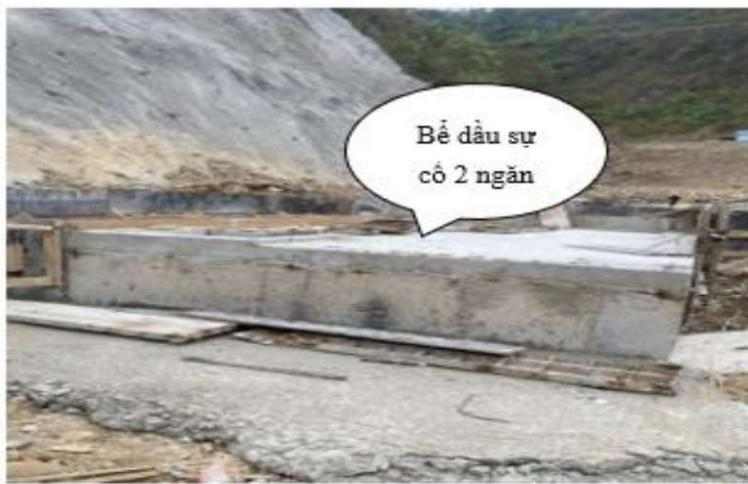
Hình 17: Bể dầu sự cối khu vực trạm biến áp
