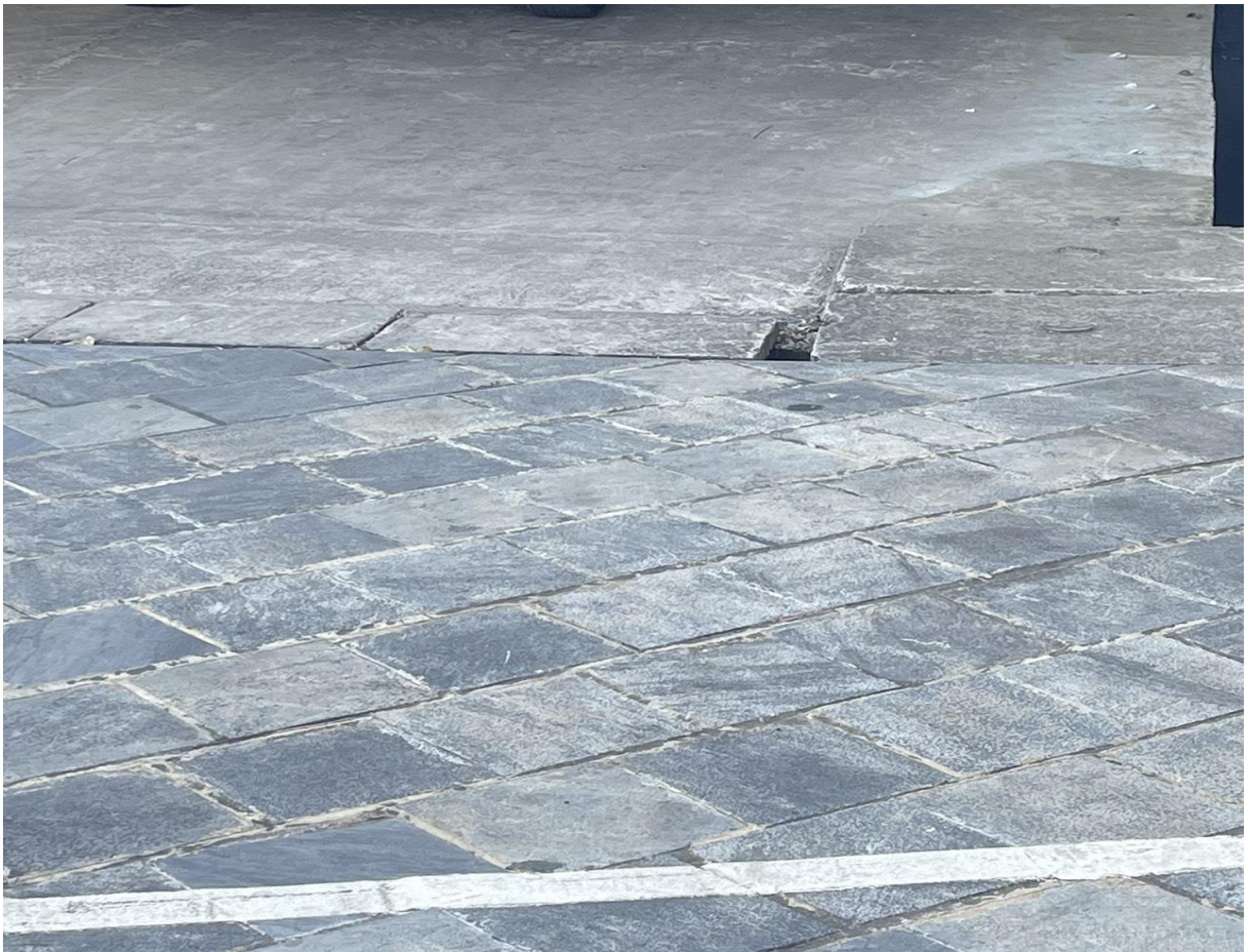
Hình 6: Hình ảnh hệ thống rãnh thoát nước mưa
